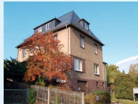
Ärztehaus Bornaer Straße 79 in Chemnitz. Fotos (2): Allgemeinwesen
