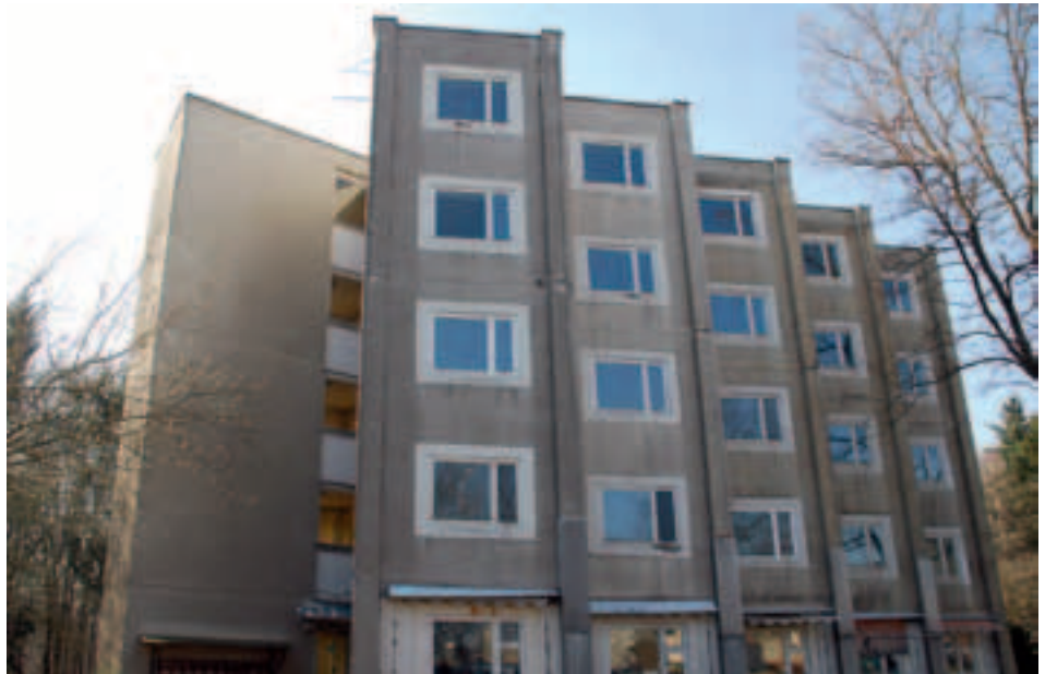
Der Probebau für das Interhotel Kongress im Küchwald-Areal, der Schwesternwohnheim und später auch als Betriebskindergarten genutzt wurde. Das Stahlbetongebäude ist inzwischen abgerissen worden. Foto: Kreißig; Archiv MA/ÖA
