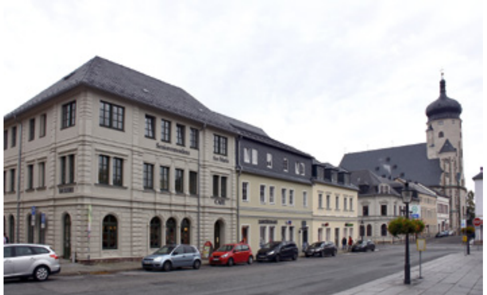
Mit der Sanierung der Gebäude für die Seniorenresidenz Am Markt ist der Marienberg wieder an allen Seiten architektonisch intakt.
